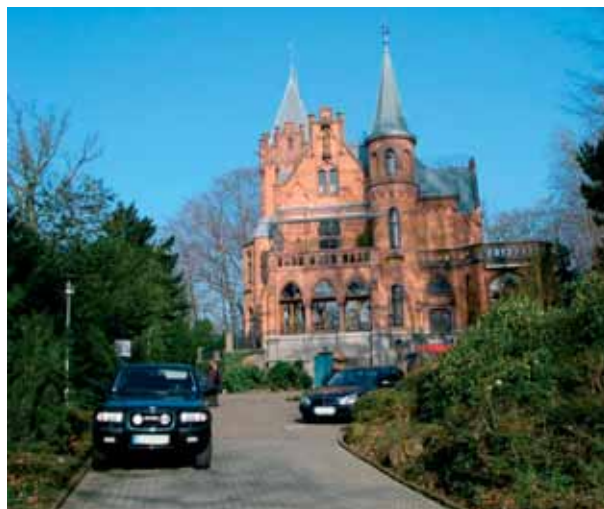
Hirschburg, Objekt mit Brandmeldeanlage
